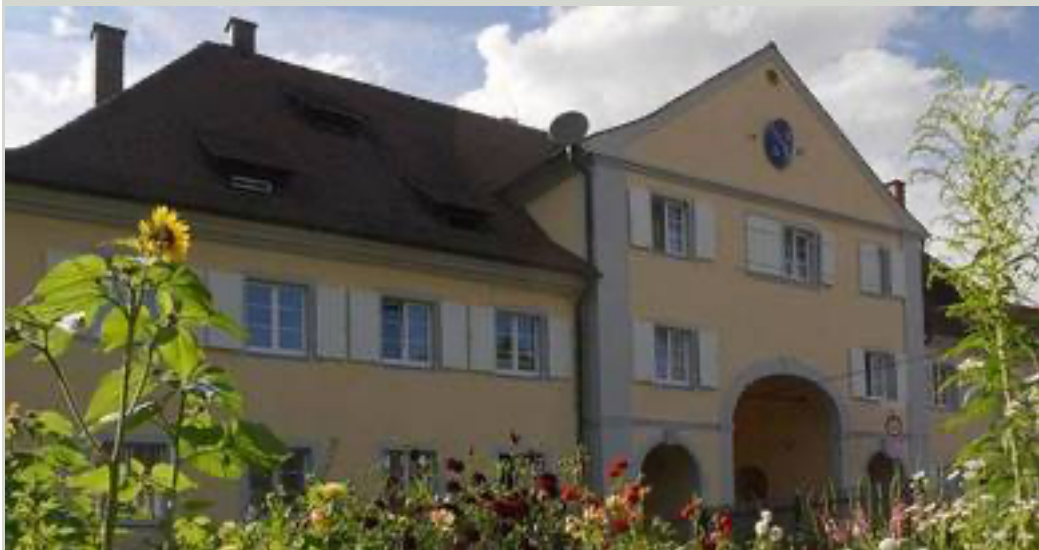
Eingang zum Klosterbereich und ehemals „Bollwerk“ gegen die Außenwelt ist das stattliche zweigeschossige Torgebäude mit hohem Walmdach. Die erhöhte mittlere Wagentdurchfahrt der drei Durchlässe ist datiert auf das Jahr 1781.
